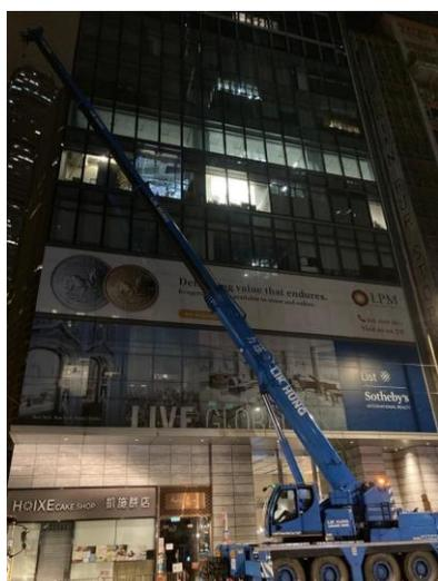
← 從已拆除的玻璃外牆運送 CT 及 MRI 到診斷中心內
